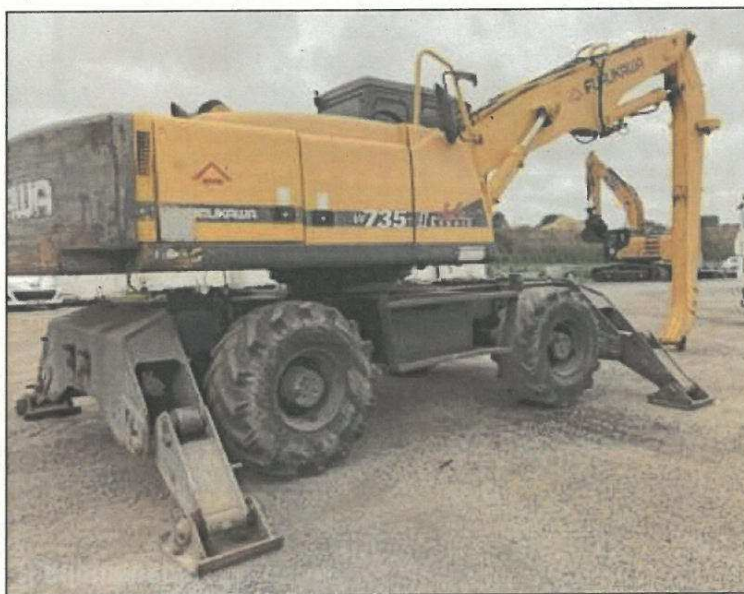
Figure 3 : Matériel utilisé pour la réalisation des puits mécaniques
